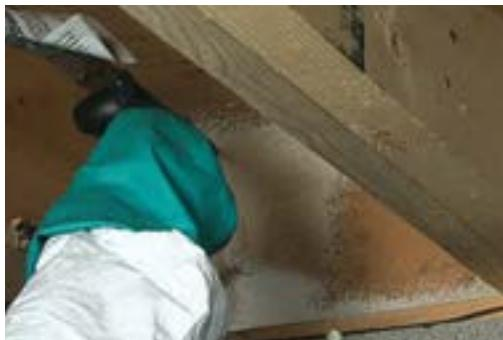
Idéale pour les systèmes d'isolation flash et matelas ou hybrides ou dans les applications où un matériau de classe 1(A) et de classe 2(B) est requis. Bloque les infiltrations d'air et offre une valeur R vieillie de 6,1 à un pouce d'épaisseur pour un système d'isolation économique et efficace.
