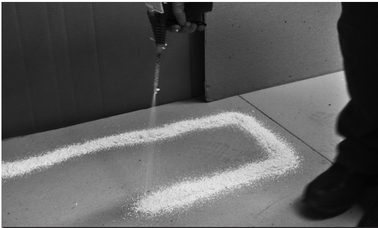
APLICACIÓN DEL ADHESIVO BOARD-MAX
